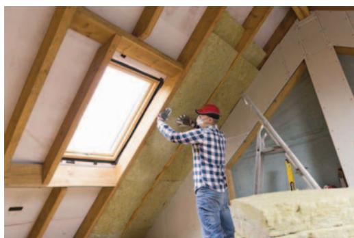
Поставување изолација во просторија под покрив
